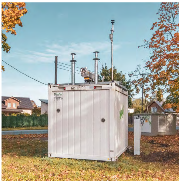
Gaisa kvalitātes monitoringa stacija Rīgā, Kantora ielā
