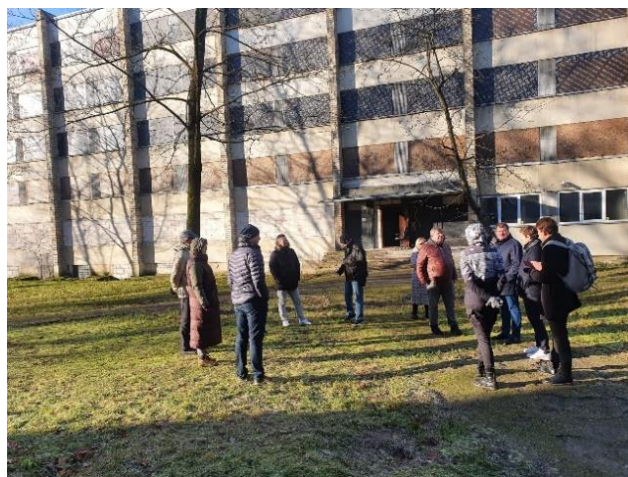
6. attēls. ULG sanāksme Ziepju ielā 11 22.11.2021.
