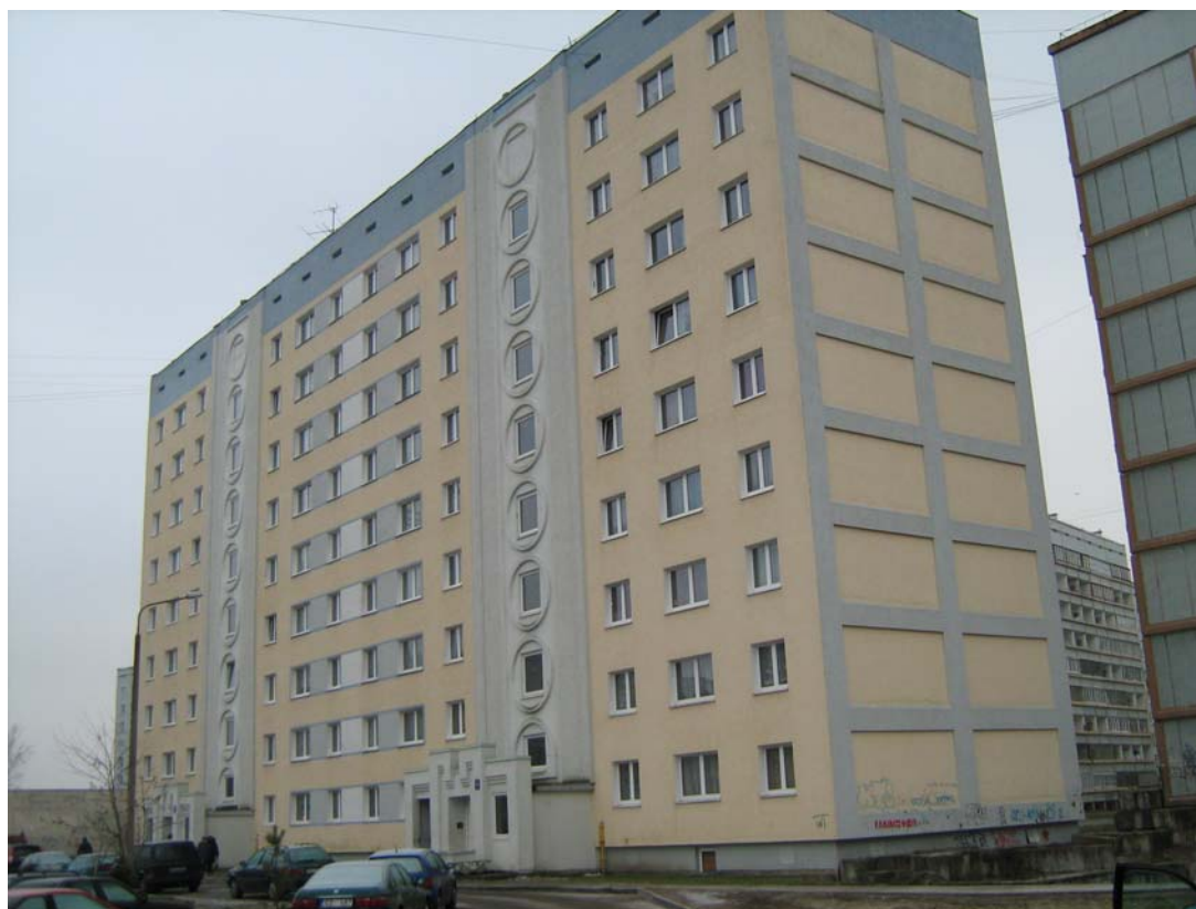
Siltinātā pirmā daudzdzīvokļu ēka Rīgā Ozolciema ielā 46/3 – 2001.g.
