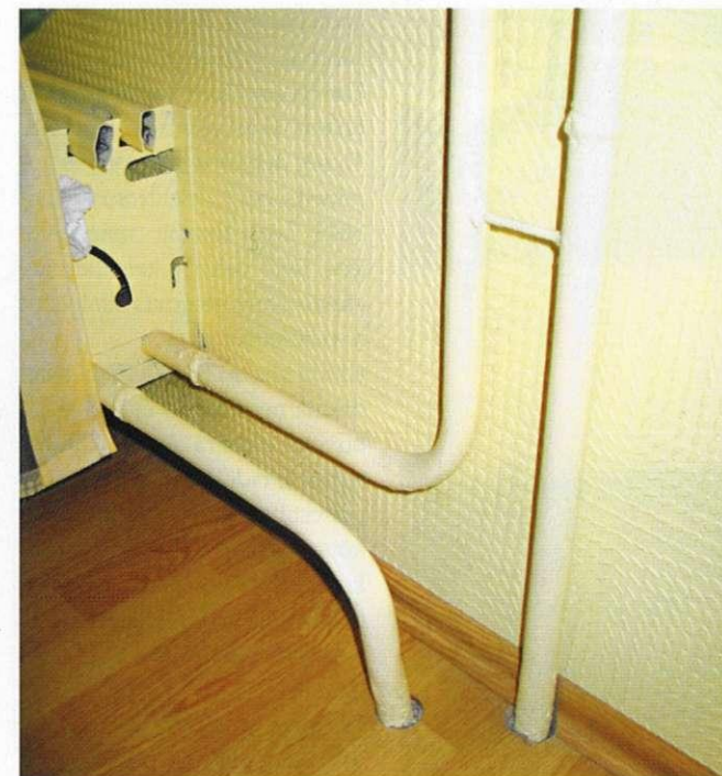
1. attēls. Oriģinālais sildķermeņa pieslēgums dzīvoklī.
