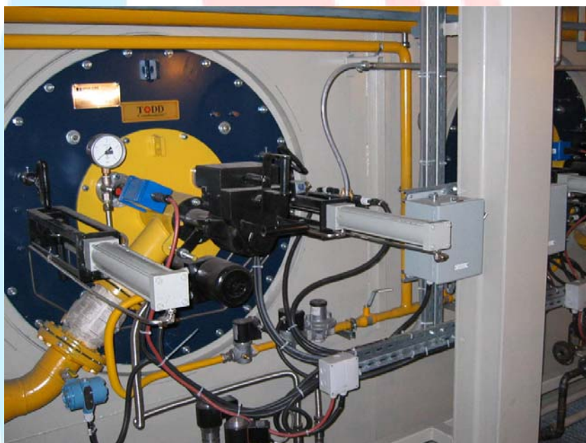
Attēls 2. SC „Imanta” katla KVGM-100 frontālā daļa pēc rekonstrukcijas
